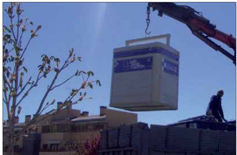
En la imagen, la colocación de uno de los nuevos contenedores
